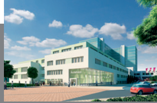
Links Ansicht Eingang
